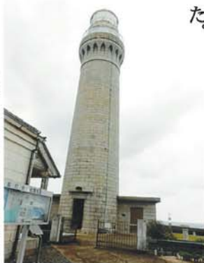
角島灯台：明治9年完成。重要文化財。
